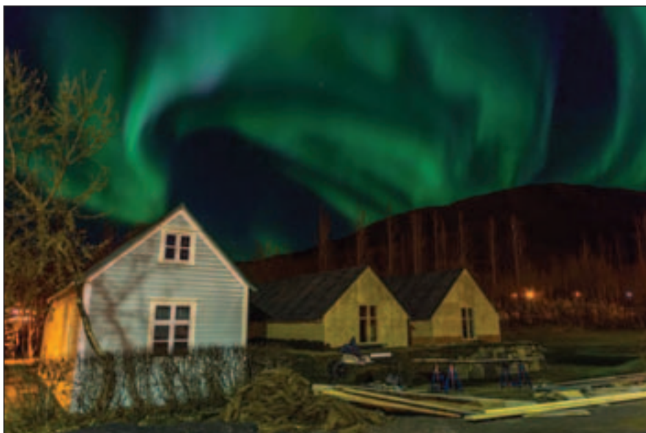
Kvíabekkur, baðaður í skini norðurljósa á mynd Hreins Hjartarson. Nánast er búið að loka og ganga frá nýbyggingu „gamla“ torfbæjarins fyrir veturinn. Og nú vantar bara meira fjármagn til að halda áfram með þessar framkvæmdir.
